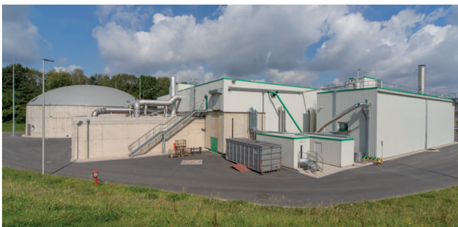
Das Herzstück der seit 2012 betriebenen Anlage ist der Fermenter. Hier werden Bio-Abfälle in Methangas umgewandelt.
